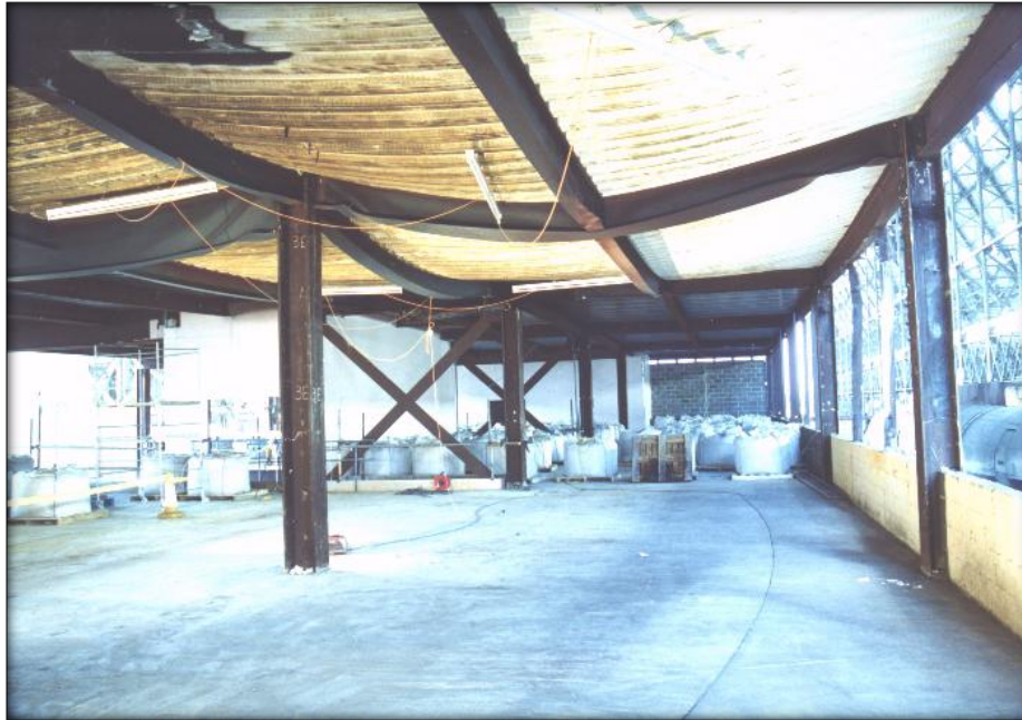
Obrázok 1 Ohyb konštrukcie namáhanej požiarom (Sokol, 2003)
