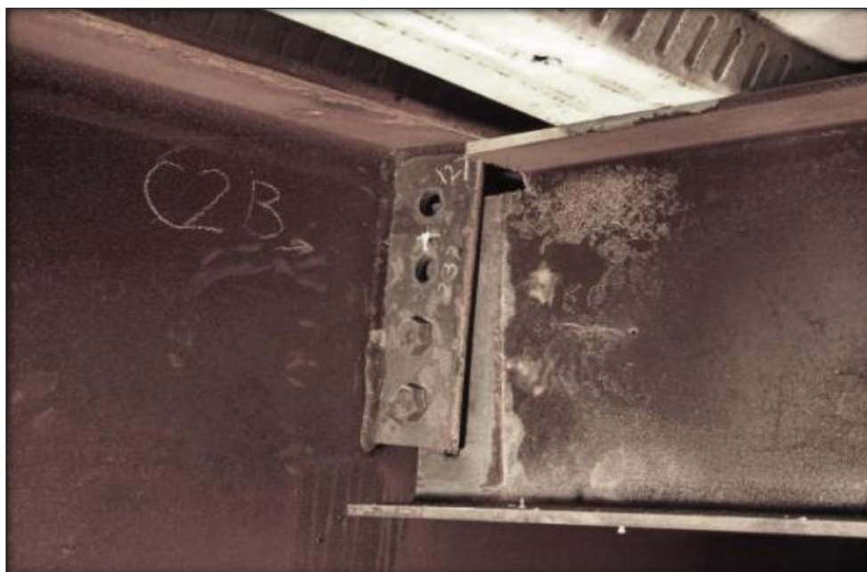
Obrázok 2 Povolenie skrutiek na konštrukcii namáhanej požiarom (Sokol, 2003)
